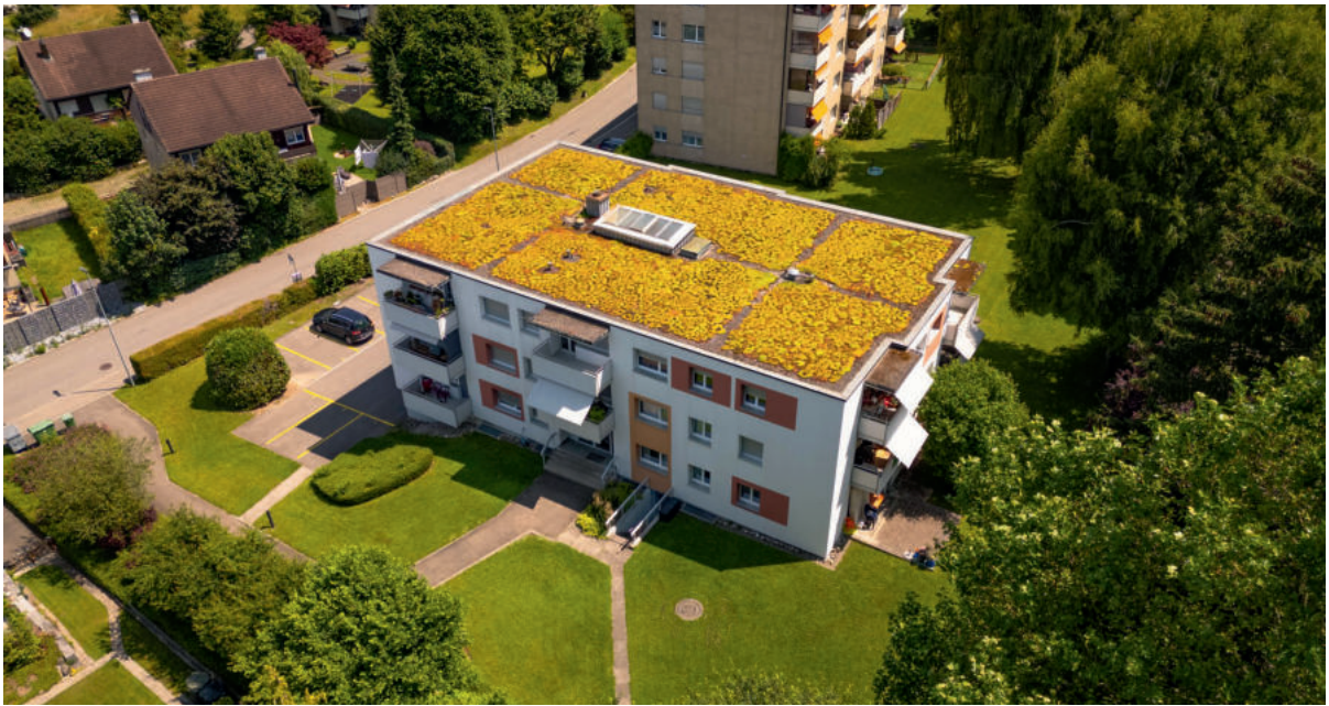
Wohngebäude AKISP in Rüti ZH
