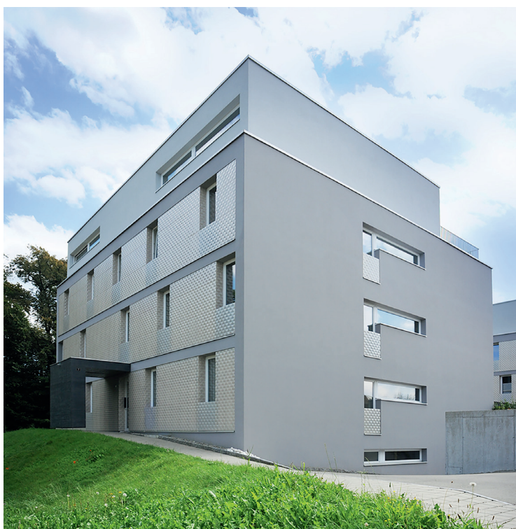
Wohngebäude AKISV in Rupperswil AG
