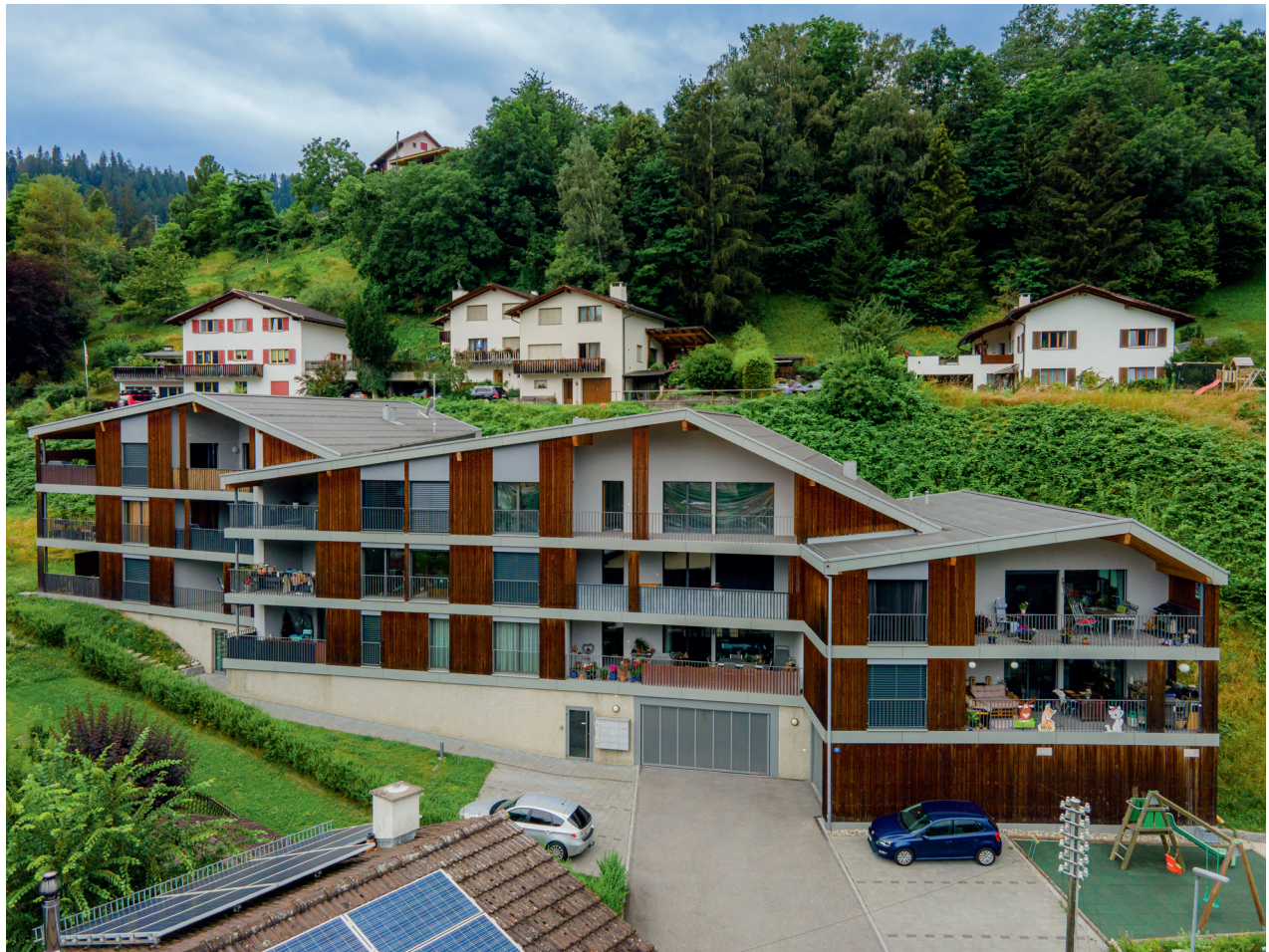
Wohngebäude AKISV in Summaprada GR
