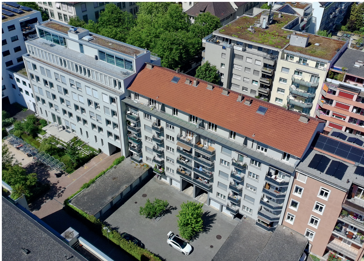
Wohngebäude AKISV in Basel BS
