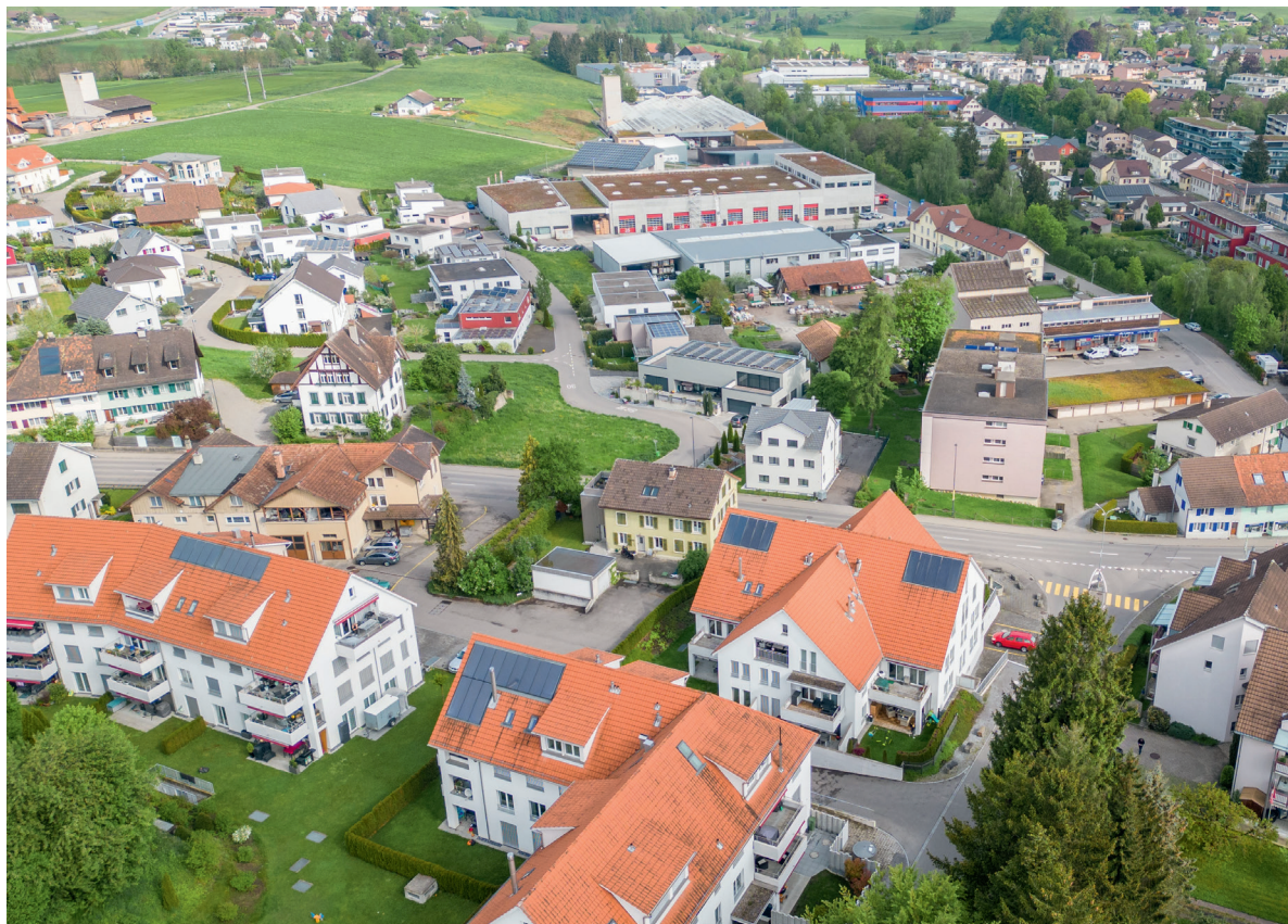
Wohngebäude AKISV in Wängi TG
