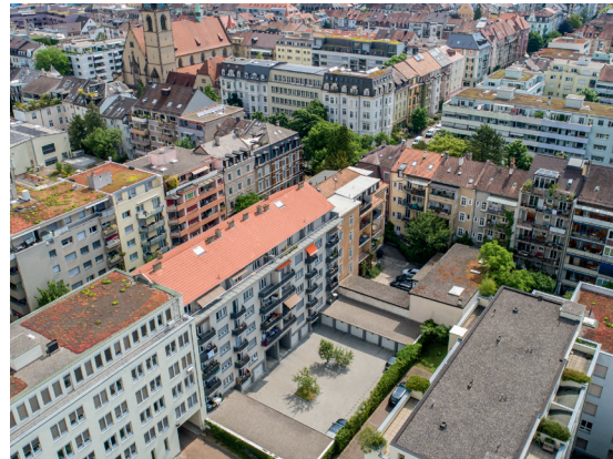
Wohngebäude AKISV in Basel BS
