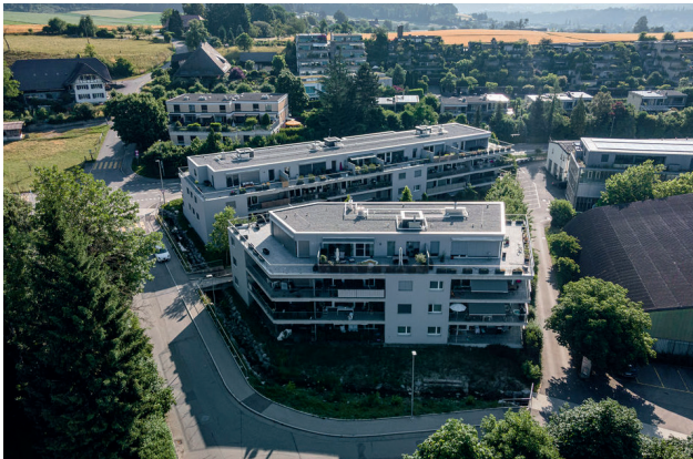
Wohngebäude AKISV in Herrenschwanden BE
